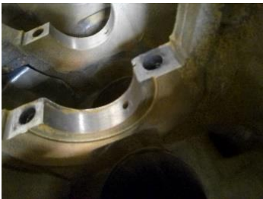
Figura 30. Cajón axial en buen estado
