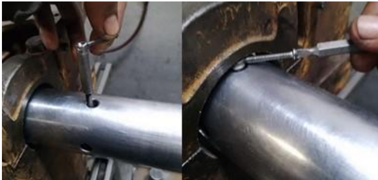
Figura 87. Proceso de medición de bancada
