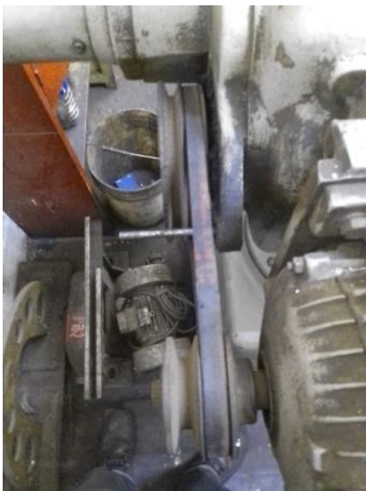
Figura 24. Poleas del motor eléctrico
