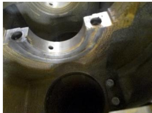
Figura 29. Cajón axial en mal estado
